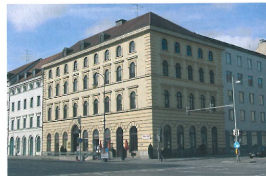
Licht und Schatten herrscht in der Münchner Firmenzentrale.
